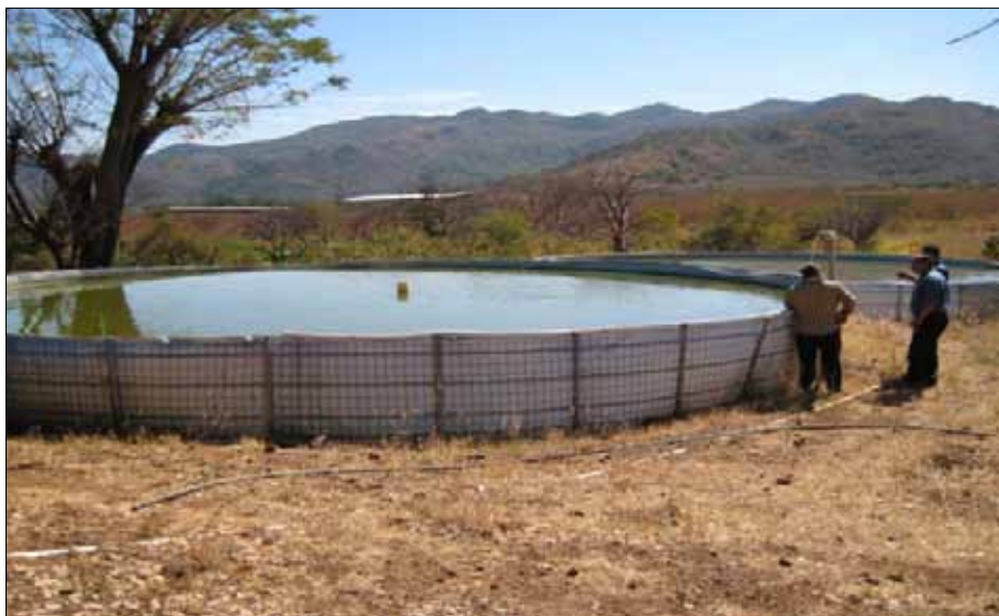
Figura 2. Estanque de geomembrana.
